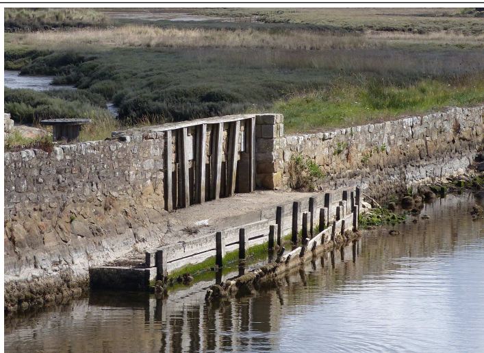
Déversoir coté amont
