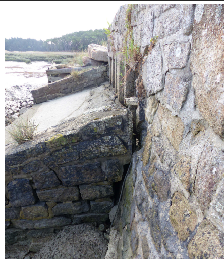
Déversoir coté aval
