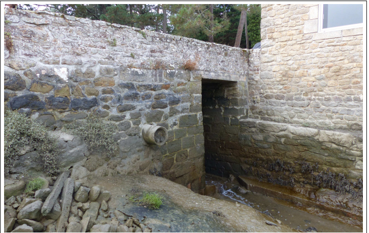
Vannage coté aval
