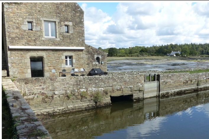
Canal usinier et vannage coté amont
