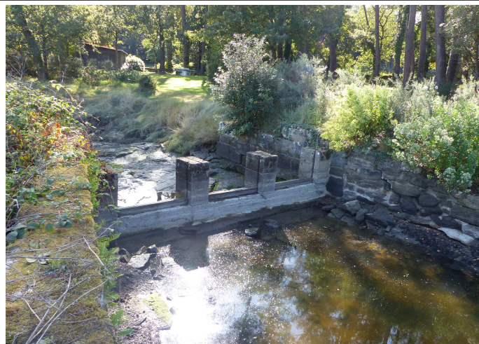
Ouvrage adjacent : seuil coté amont
